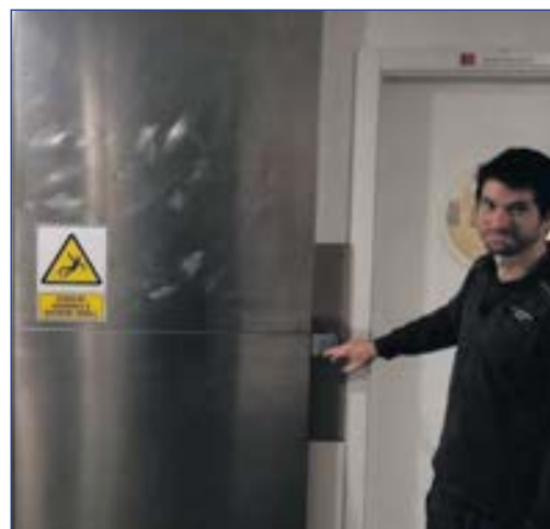
Polsador d'obertura i il·luminació al parc de Sant Andreu. Porta metàl·lica d'accés a l'espai de descens
