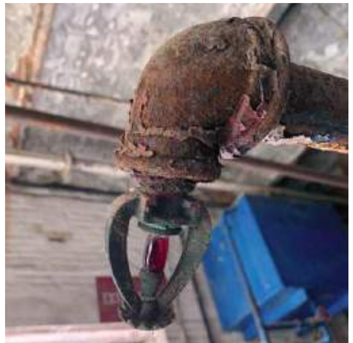
Instal·lació d'extinció automàtica d'aigua (Sprinkler). Foto: Joan Pedreny
